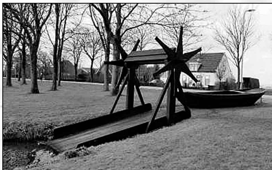
Voorbeeld van een overhaal. Deze overhaal ligt in Venhuizen tussen de polders Het Grootslagen de polder De Drieban. Foto uit 2006.
