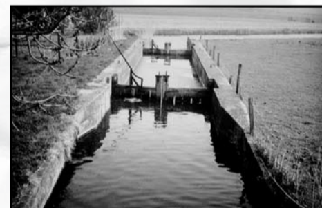
De sluis aan de 'Koedijker' kant. Hoewel niet meer in functie is. Deze sluis nog steeds te zien. Bij deze sluis werden de schuiven om te schutten met handels bediend.
