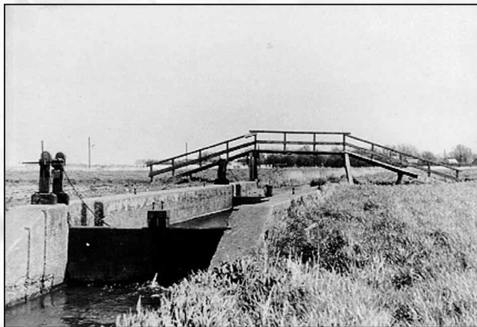
De oostelijke sluis. Let op de ringketten voor het openen van de schuiven in de sluisdeuren om te schutten.
